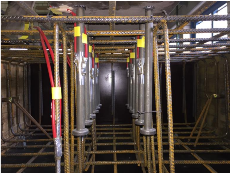
Abb. 5.13: Dehnungsmessstreifen an Kopfbolzen und Rückhängebewehrung
