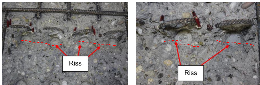
Abb. 3.29: Kontrolle der induzierten Risse nach Versuchsende – B2-N
