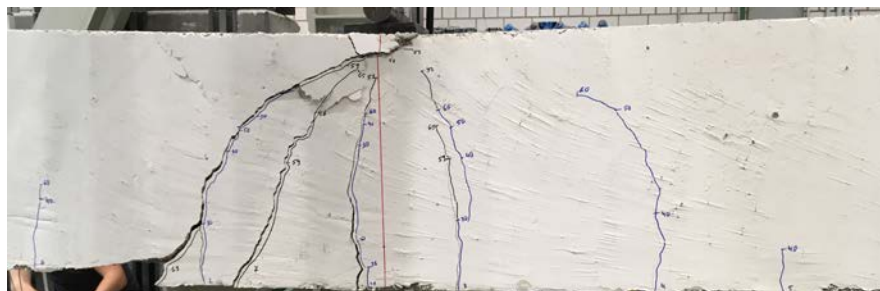
Abbildung C-49: Rissbild des Prüfkörpers am Versuchsende
