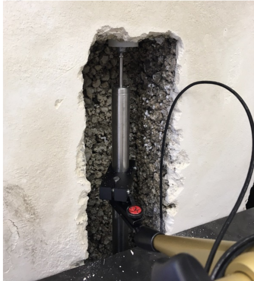
Abbildung 4-17: Freigelegter Bereich mit Wegaufnehmer
