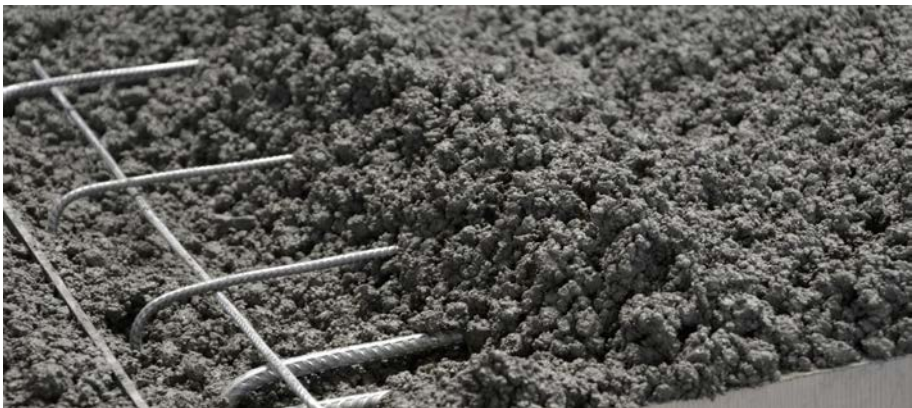
Abbildung 1-1: Unverdichteter haufwerksporiger Leichtbeton im Herstellungsprozess
