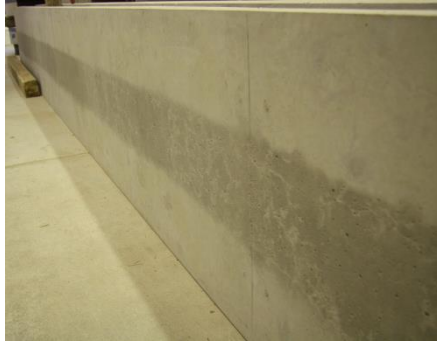
Abbildung 4-2: gestrahlte Betonoberfläche
