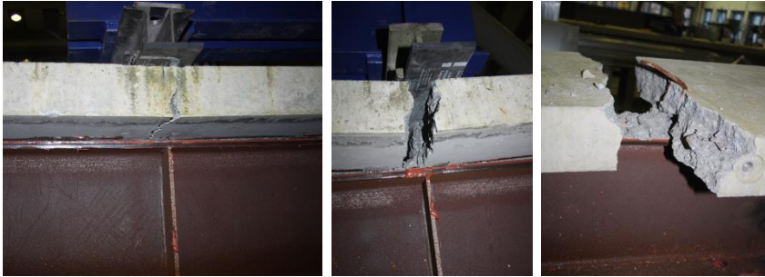
Abbildung 4-21: (links) Riss an der Lasteinleitung V, (mittig) Riss an der Lasteinleitung H, (rechts) Riss im Bereich der hinteren Lasteinleitung und Auflagerung
