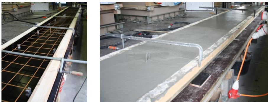
Abbildung 4-1: (links) Schalung einer Betonplatte, (rechts) frisch betonierte Betonplatte
