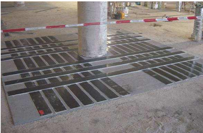
Abbildung 1-18: CFK-Lamellen der Firma BAUTAS AG
