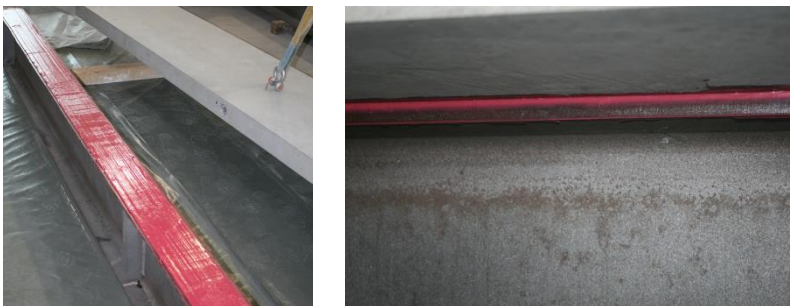
Abbildung 4-5: (links) Klebstoff auf dem Stahlträgerflansch, (rechts) Klebfuge im Endzustand
