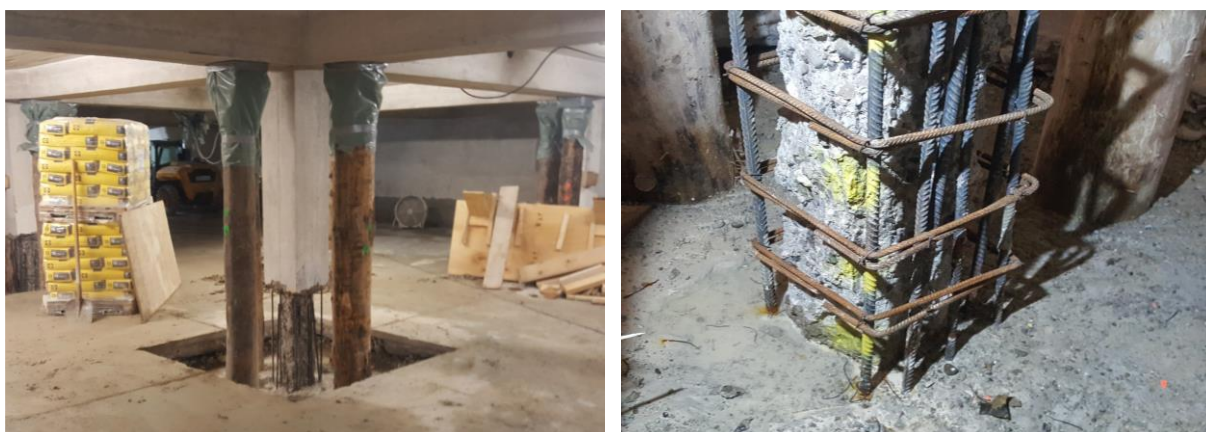
Abbildung 3-4: Abstützmaßnahmen und Betonabtrag bei Stützeninstandsetzung mittels Verfahren R-CI bzw. Verfahren 7.2; Bild: id+v, Rommel
