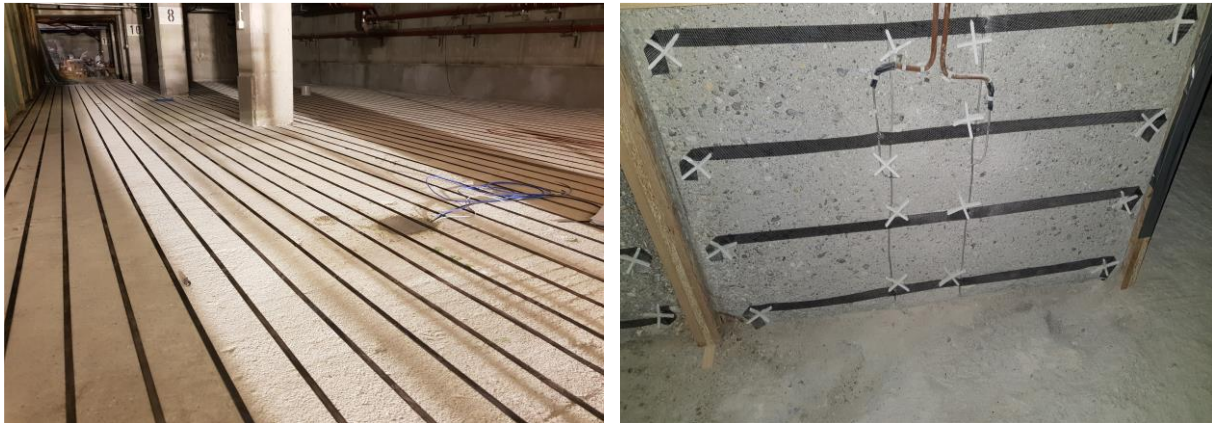
Abbildung 3-5: Einbau Bandanoden bei Tiefgarageninstandsetzung mittels Instandsetzungsprinzip KKS bzw. Verfahren 10.1, Bild: id+v, Becker
