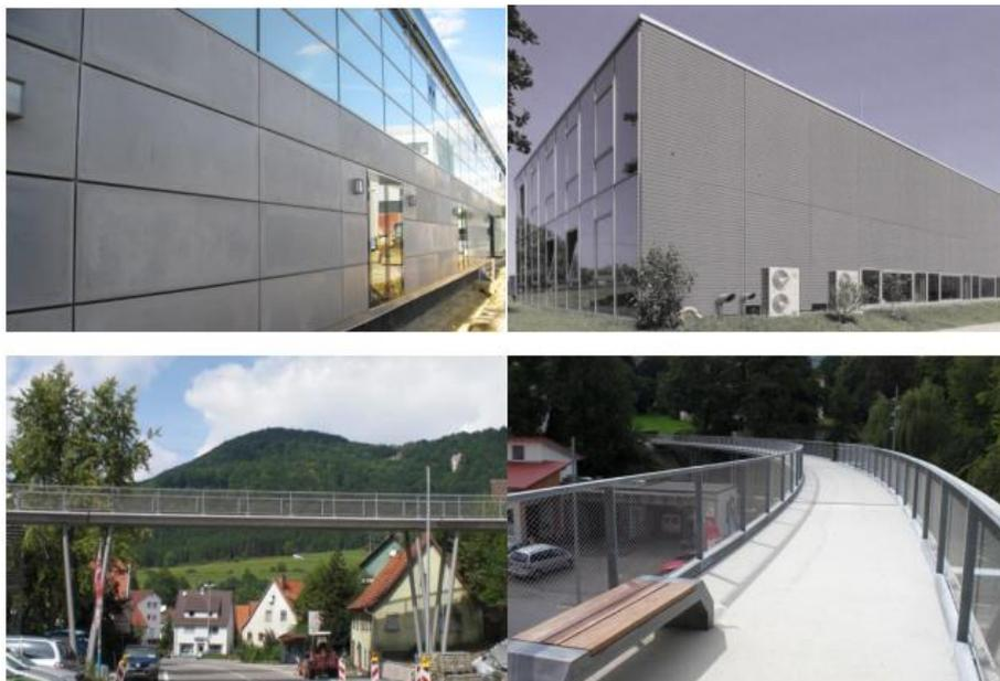
Abb. 2-7: Realisierte Anwendungen aus Textilbeton auf Basis der Ergebnisse des SFB 532<sup>10</sup>
