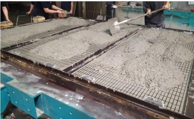
Abbildung B.6-2: Betonieren der Versuchskörper
