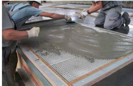
Abb. 2-12: Schalenförmige Textilbetonstruktur und Produktion von Textilbetonbauteilen aus Feinbeton <sup>16</sup>
