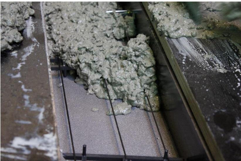
Abbildung B.5-2: Rovings und Füllen der Schalung
