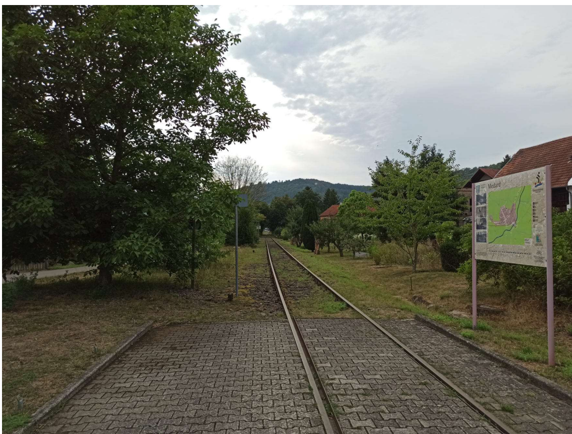
Abbildung 9: Standort der empfohlenen Station Medard bei Kilometer 77,6. Die Bildaufnahme wurde vom BÜ in der „Schulstraße“ angefertigt und zeigt die Blickrichtung Lauterecken. (eigene Aufnahme)
