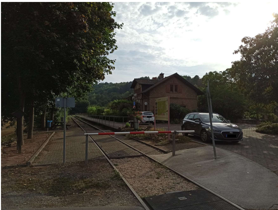
Abbildung 6: Standort der ehemaligen und empfohlenen Station Raumbach bei Kilometer 86,8; Blick vom BÜ der Landesstraße 376 gen Meisenheim. (eigene Aufnahme)
