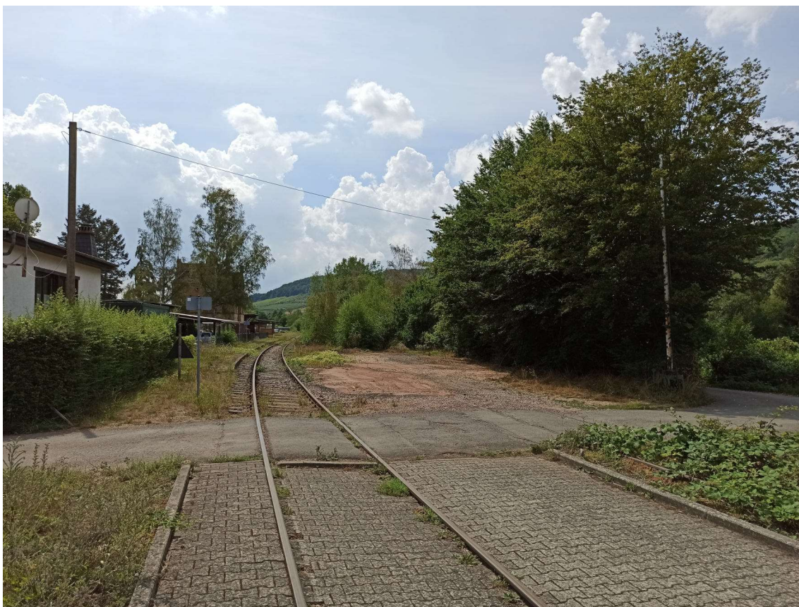
Abbildung 4: Empfohlener Standort der Station Odernheim an Streckenkilometer 93,2. Blick vom Bahnübergang (BÜ) in Richtung Rehborn. (eigene Aufnahme)
