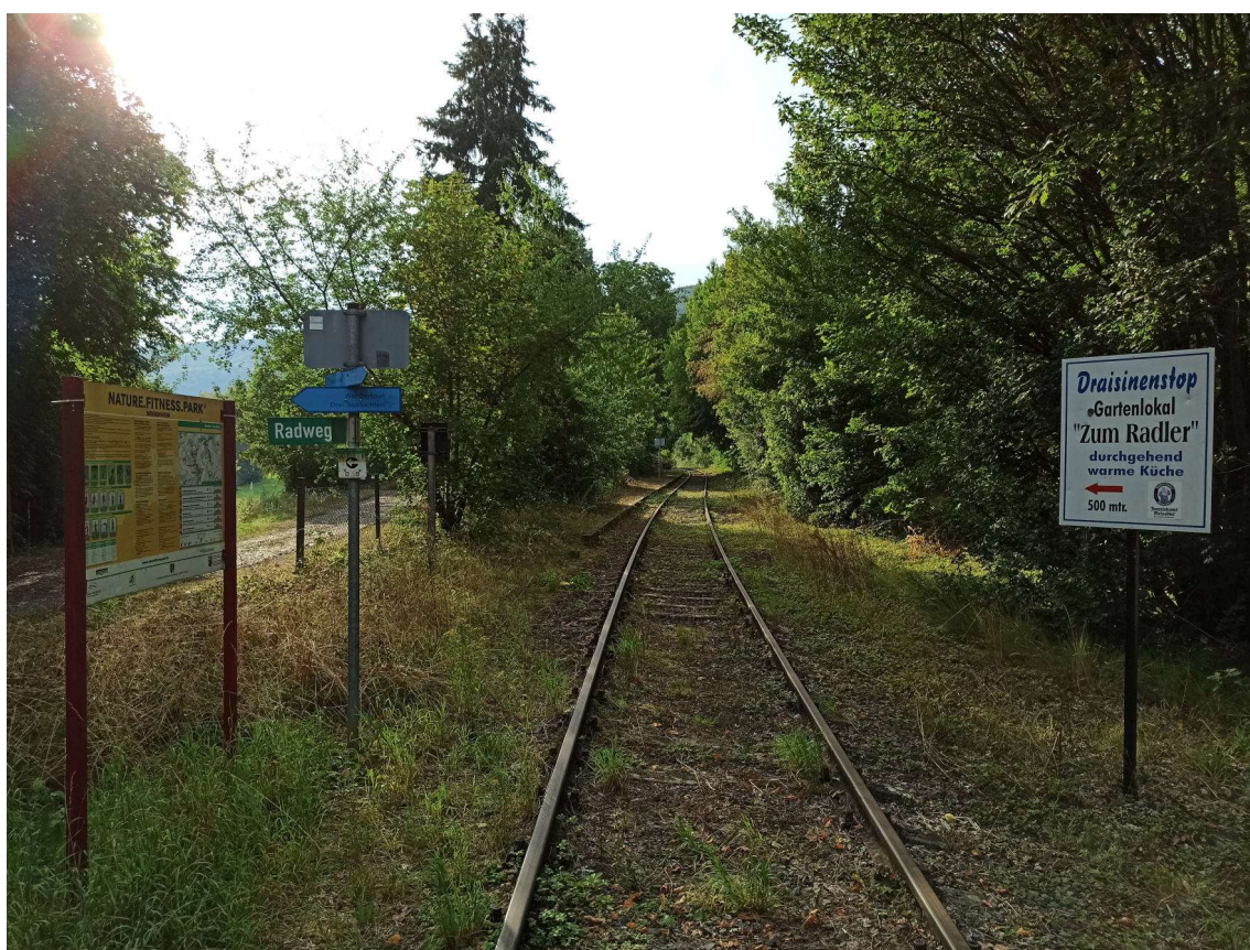
Abbildung 5: Empfohlener Standort der Station Rehborn bei Kilometer 89,4. Blick vom BÜ zum Antoniusshof mit Blickrichtung Meisenheim. (eigene Aufnahme)
