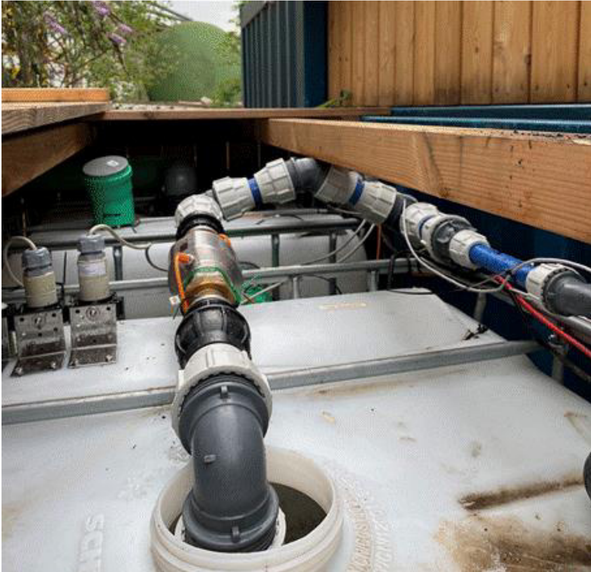
Abbildung B - 2: MID-Durchflussmessgerät mit künstlichem Höchstpunkt zum Einstau der MID-Teilstrecke im Zulauf der Bodenfilteranlage im Pilotmaßstab.
