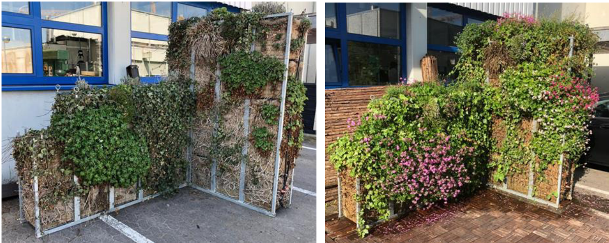
Abbildung 3-5: Grüne Wand bei der Anlieferung (links); und grüne Wand nach Bewässerung mit aufbereitetem Grauwasser.
