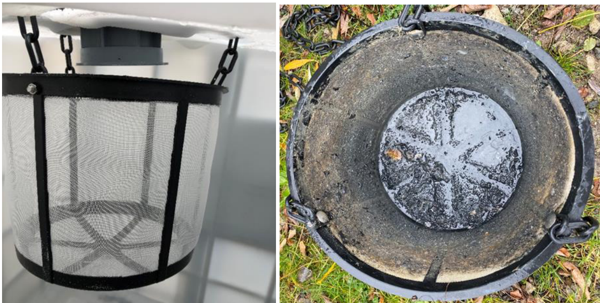
Abbildung 3-9: Im Speicher eingebauter, gereinigter Grobschmutzfilterkorb (Maschenweite = 1,3 mm) [links] und ausgebauter, ungereinigter Grobschmutzfilterkorb der Fa. Green Life GmbH (rechts) zur Vorbehandlung von Grauwasser.
